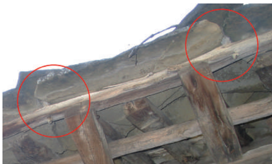
Фиг.6: Плоча от каменния перваз с характерно оформени „уши“, фиксирана чрез клечки към дървения перваз; дворна порта с. Скорците
