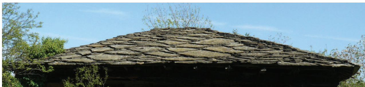
Фиг.4: Покрив, реализиран с различни по размер каменни плочи; стопанска постройка с. Скорците (снимка Л. Люцканова)
