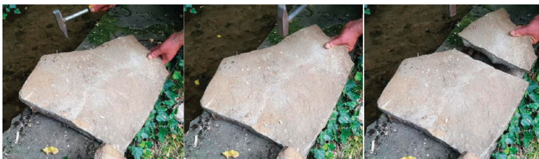
Фиг.5: Оформяне на плочите - маркиране, равномерни удари с чук, разчупване; демонстрация
